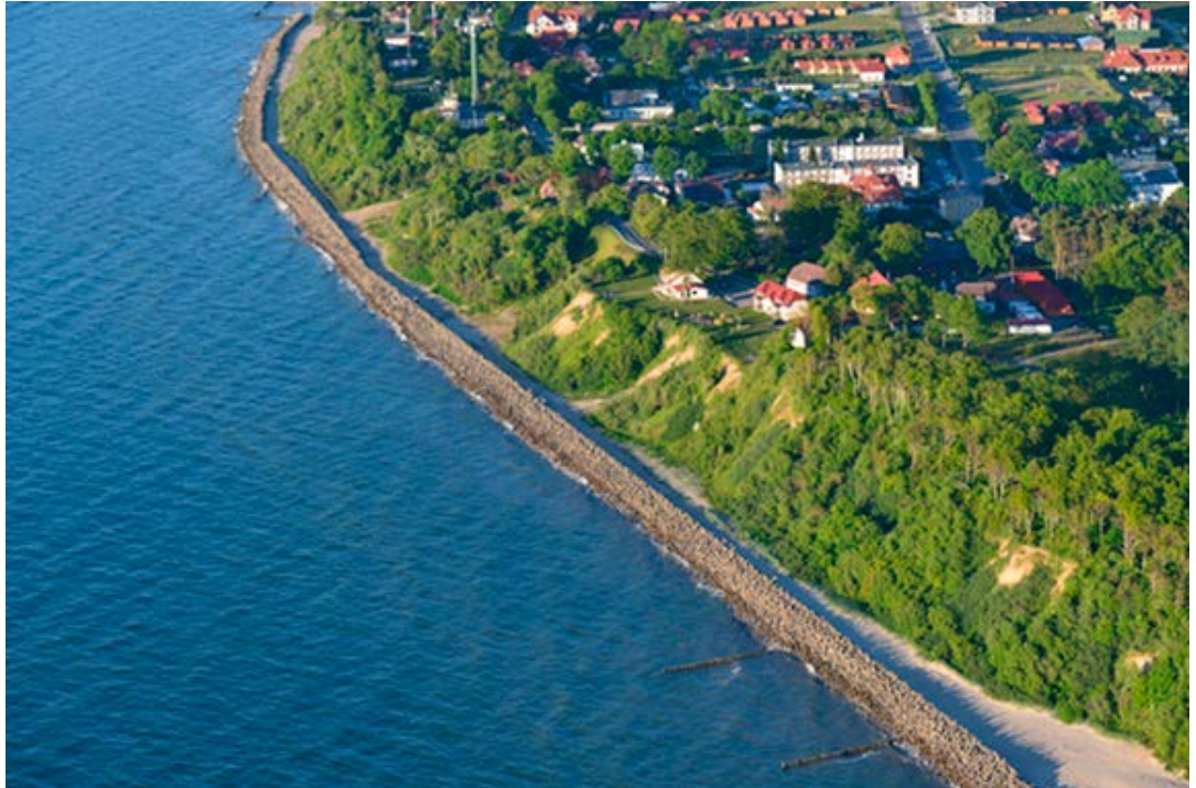
Fot. 2. Wybrzeże klifowe w Jarosław- cu. Opaska brzegowa chroniąca ląd przed erozją
