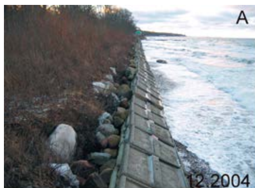
Ryc. 39A. Zmiany plaży w Kołobrzegu, rejon Szańca Wschodniego 2004–2007, A –refulat odłożony w połowie 2004, rozmyty dnia 23.11.04, grudzień 2004, B – refulacja z 09.2005, styczeń 2006, C – po sztormie z 01.11.2006, listopad 2006, D – p sztormie z 18.01.2007, luty 2007
