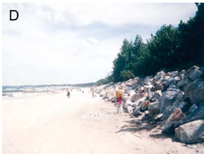
Ryc. 24. Zabiegi ochrony brzegu I, A – opaska narzutowa z gwiazdobloków, Rewal 2001, B – ścianka szczelna z oczepek stalowym, Kołobrzeg 2006, C – podcięty refulat w Mrzeżynie, 2006, D – okładzina z kamienia łamanego, Ustka 2002
