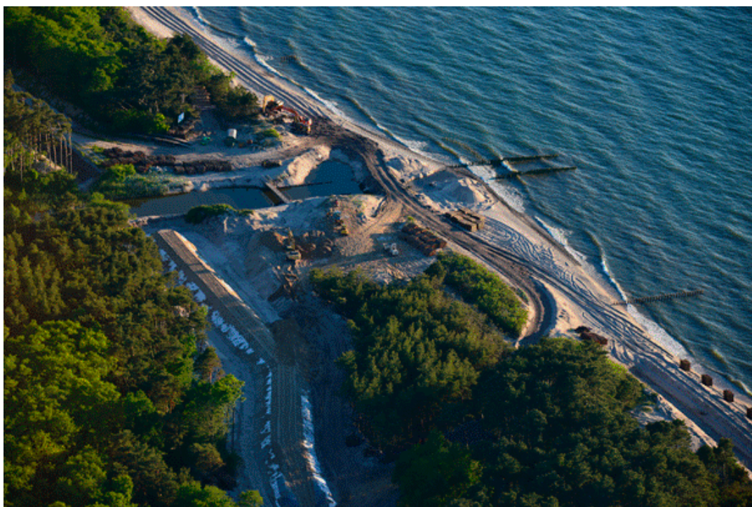
Fot. 23. Naturalna Mierzeja Jeziora Kopań w zabudowie. Z obawy przed przerwaniem mierzei i wlewem wody do jeziora rozpoczęto kompleksową przebudowę zabezpieczeń. To swego rodzaju walka z naturą pochłaniającą ogromne środki finansowe
