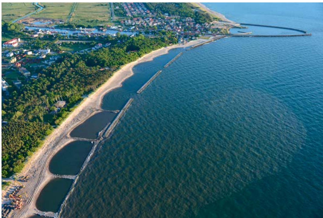
Fot. 12. Falochrony w Dartówku przy ujściu Wieprzy, po stronie wschodniej z powodu erozji wybudowano opaskę i falochrony. W latach 2012-2014 rozbudowywane są te umocnienia na odcinku 8 km, łącznie z mierzeją jeziora Kopań, za kwotę ponad 200 mln zł
