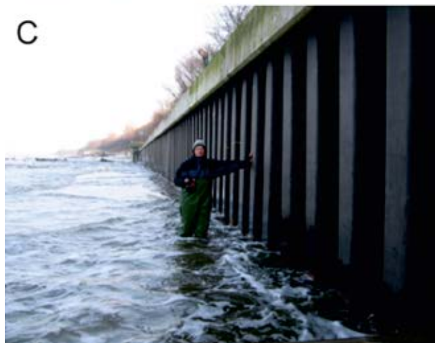
Ryc. 24. Zabiegi ochrony brzegu I, A – opaska narzutowa z gwiazdobloków, Rewal 2001, B – ścianka szczelna z oczepek stalowym, Kołobrzeg 2006, C – podcięty refulat w Mrzeżynie, 2006, D – okładzina z kamienia łamanego, Ustka 2002
