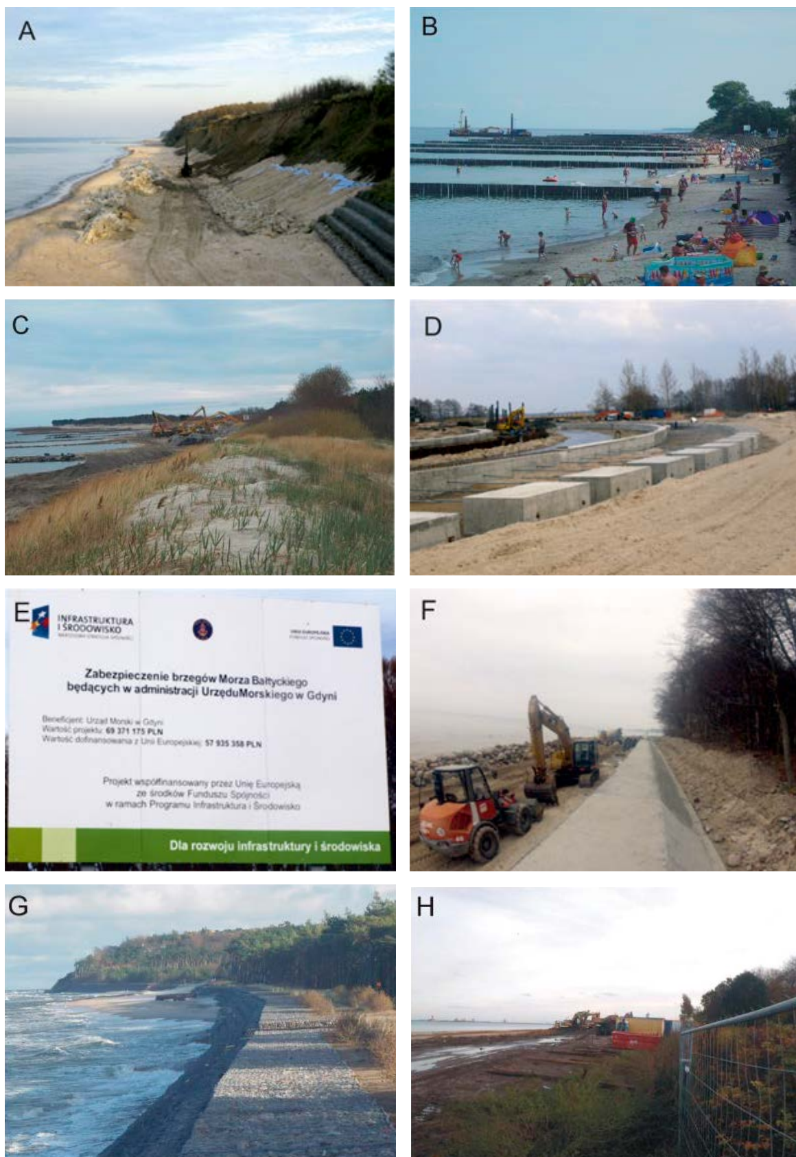
Ryc. 28. Ciężkie zabiegi, inwestycje ze środków unijnych od 2010 r. A – budowa opaski z kamienia łamanego, klif Trzęsacz, 08.2010, będzie przedłużana w 2013 r., B – budowa progów podwodnych w Kołobrzegu, widoczne nowe ostrogi, przed zasila- niem plaży, 08.2012, C – budowa progów i ostróg, Darłówek – Mierzeja Kopań, 04.2013, D – regulacja kanału Jeziora Jamno wraz z budową wrót przeciwsztormowych w Unieściu, 04.2013 E – tablica informacyjna Urzędu Morskiego w Gdyni z kwotą finansowania projektu, F – przebudowa opaski w Rozewiu, G – opaska gabionowa na naturalnym, niezamieszkałym brzegu wydmowym, Ostrowo, 11.2012, H – budowa opaski na Westerplatte, 11.2012
